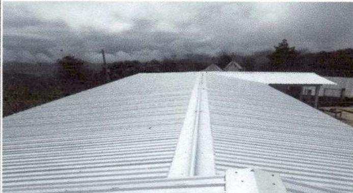
Foto1: Sustitución de lamina por lamina troquelada calibre 26.
