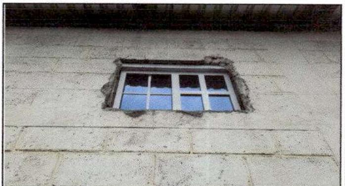
Foto 4 : Instalación y colocación de ventana, en la cocina de la escuela
